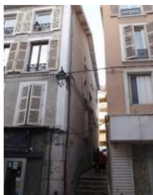
Photo Voiron Citoyenne 1 - Bâtiment ayant pignons sur Rue Grande et sur Rue Haute.
