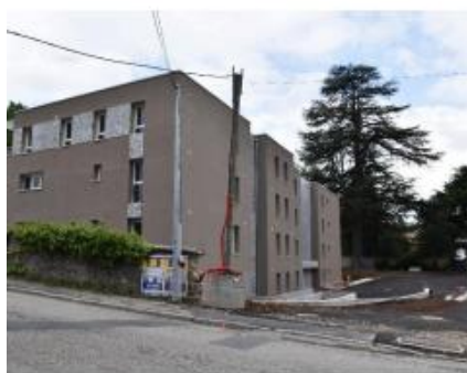
(c) État après construction
